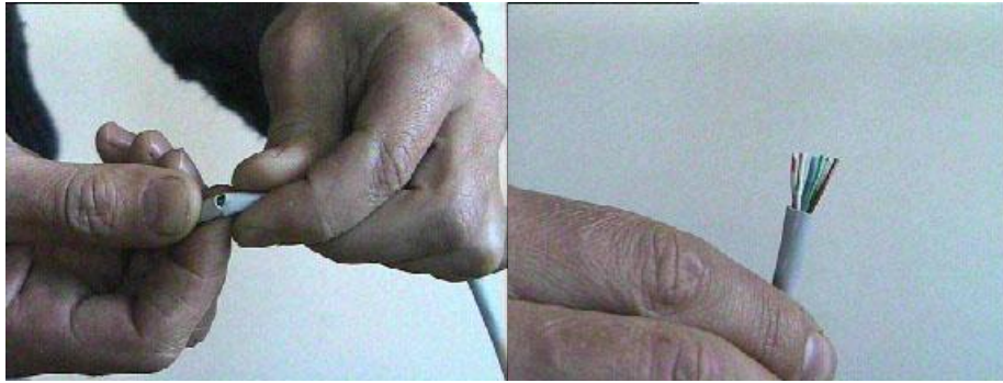
Рис.6. Удаление внешней оболочки с кабеля RJ-45
