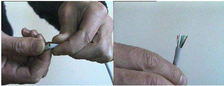
Рис.6. Удаление внешней оболочки с кабеля RJ-45
