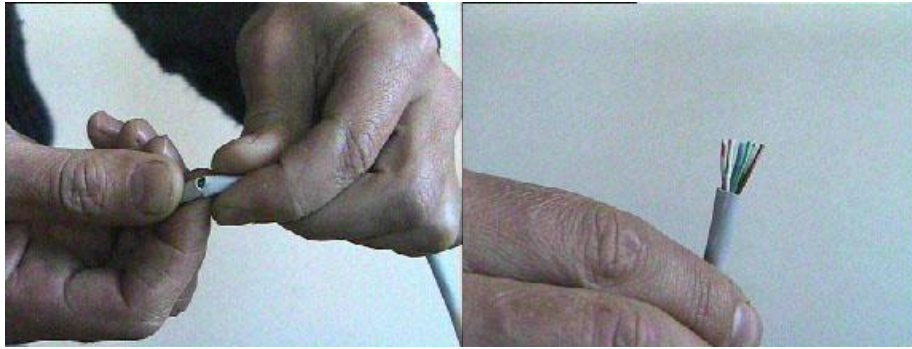
Рис.6. Удаление внешней оболочки с кабеля RJ-45
